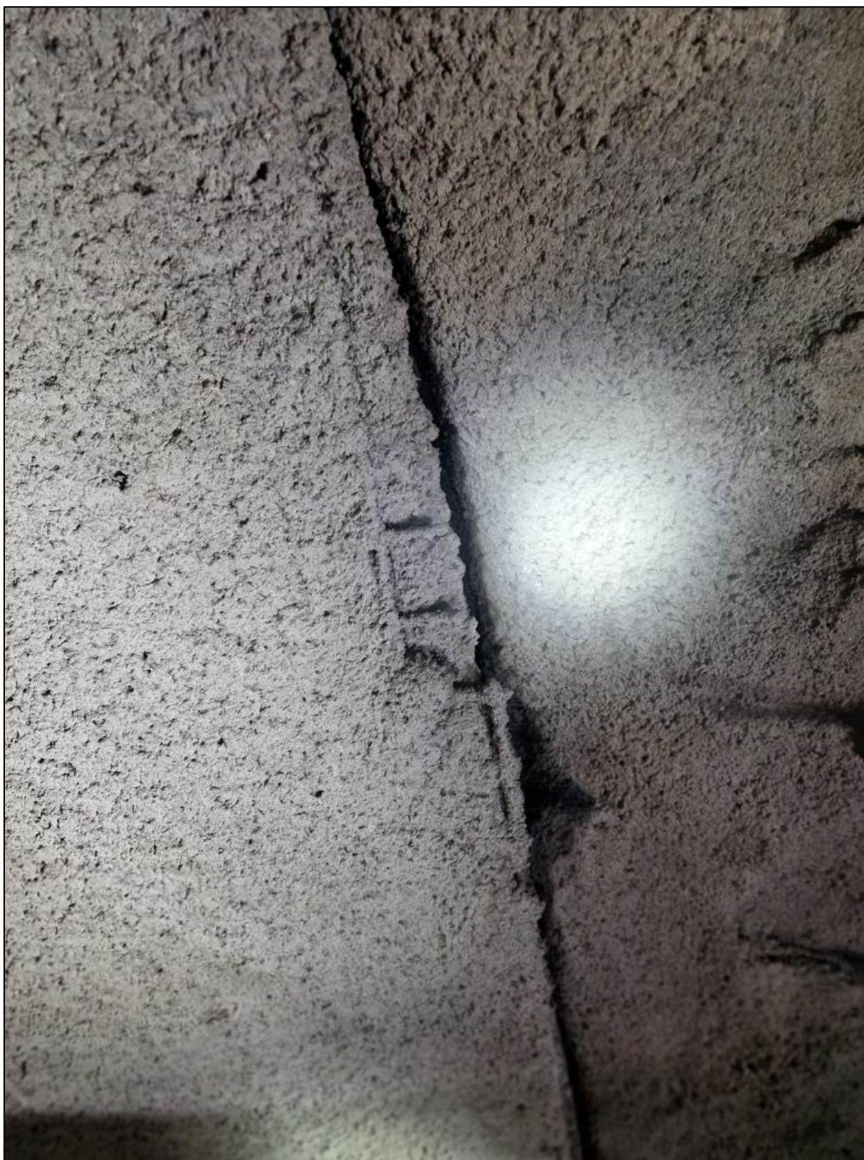
Foto 9. Åpning/synlig jern i vann- og frostsikring, pel.nr 240.
