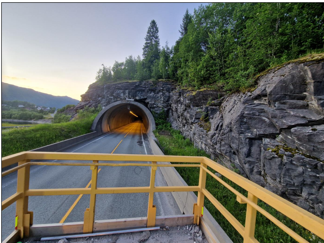
Foto 11. Oversikt forskjæring og tunnelportal sør. Grøftebredde er vurdert som tilstrekkelig.
