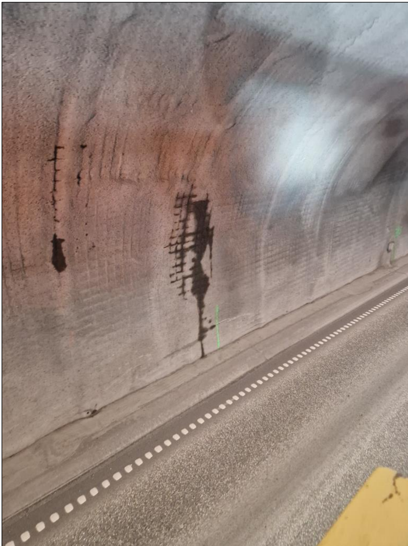
Foto 7. Et eksempel på et parti med registrert fukt, og kontur av armering i vann- og frostsikringen. Ca. pel 375
