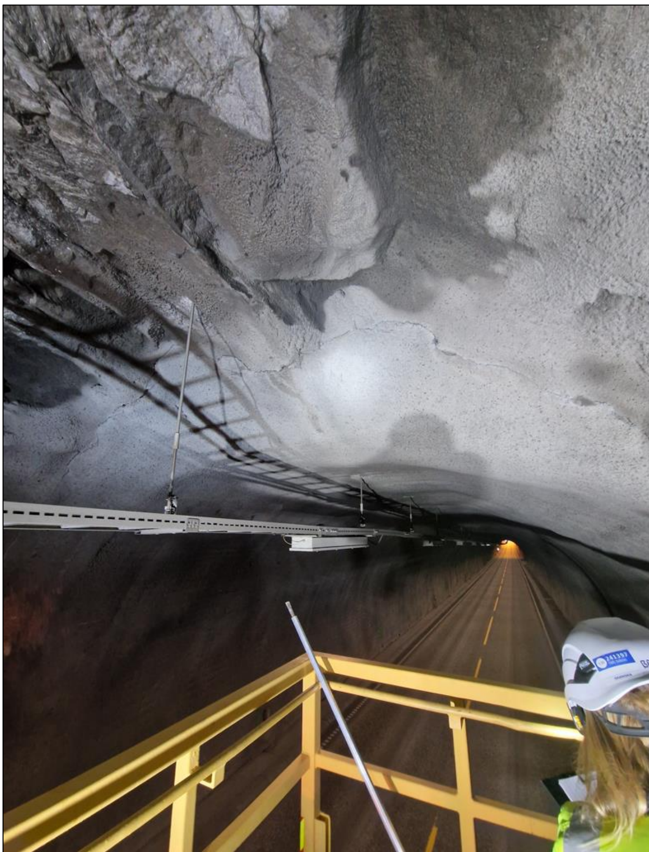
Foto 5. Pel. 415. Sprekk over hele profilet i overgang mellom brannsikret PE-skum til parti med bart berg.
