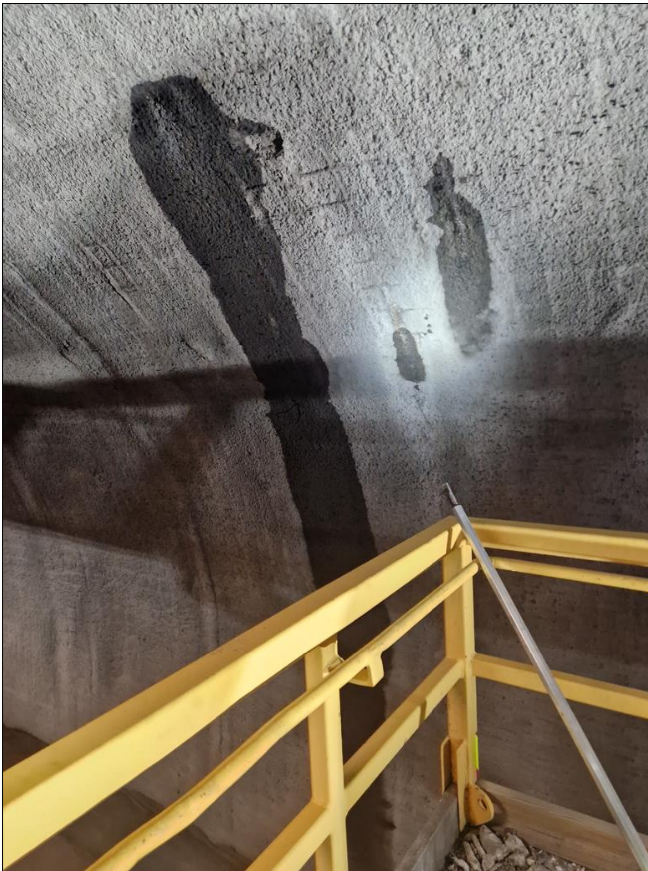
Foto 6. Et eksempel på et parti med registrert fukt, og kontur av armering i vann- og frostsikringen. Ca. pel 400.
