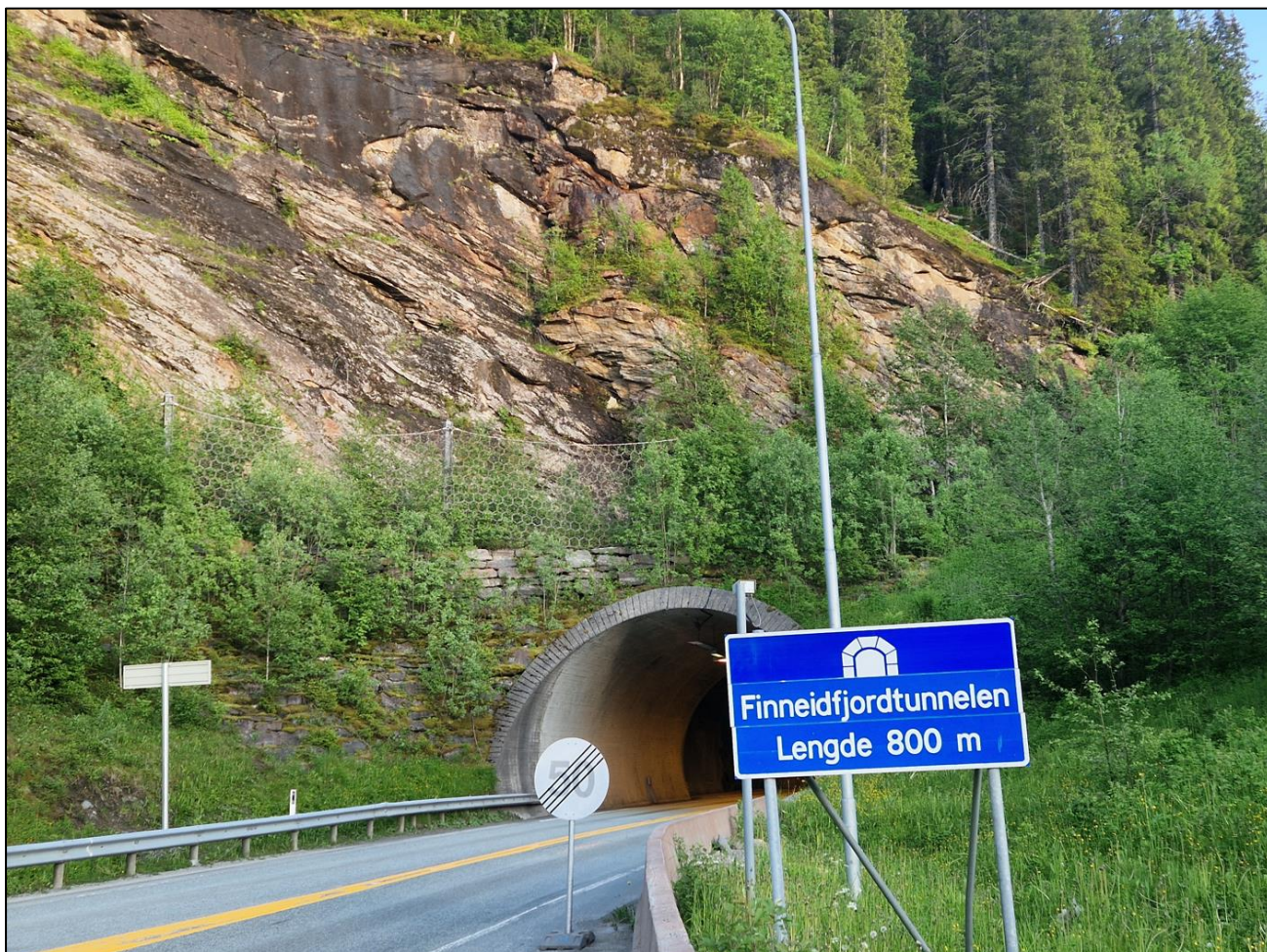
Foto 1. Oversikt forskjæring og tunnelportal nord. Forskjæringen til portalområdet er sikret med fanggjerde.
