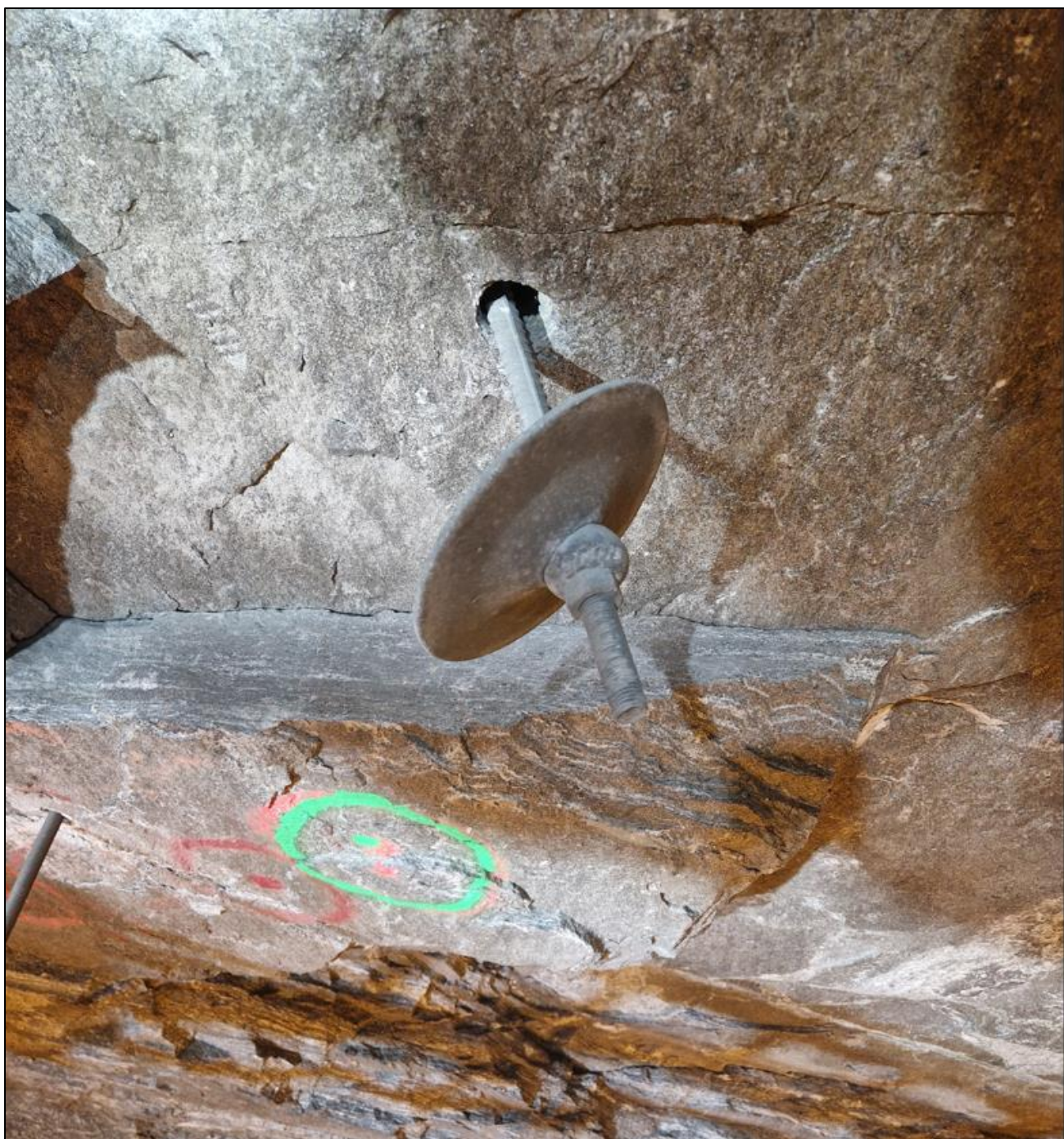
Foto 2. Pel 830 venstre heng. Løs bolt i . Anvisning av ny bombolt markert med grønt.
