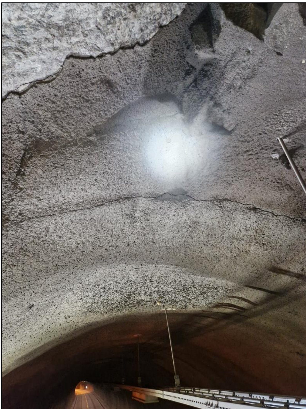
Foto 4. Sprekk i overgang fra brannsikret PE-skum til sprøytebetongsikret heng ved pel. 450. Sprekken går fra v.side mot heng.
