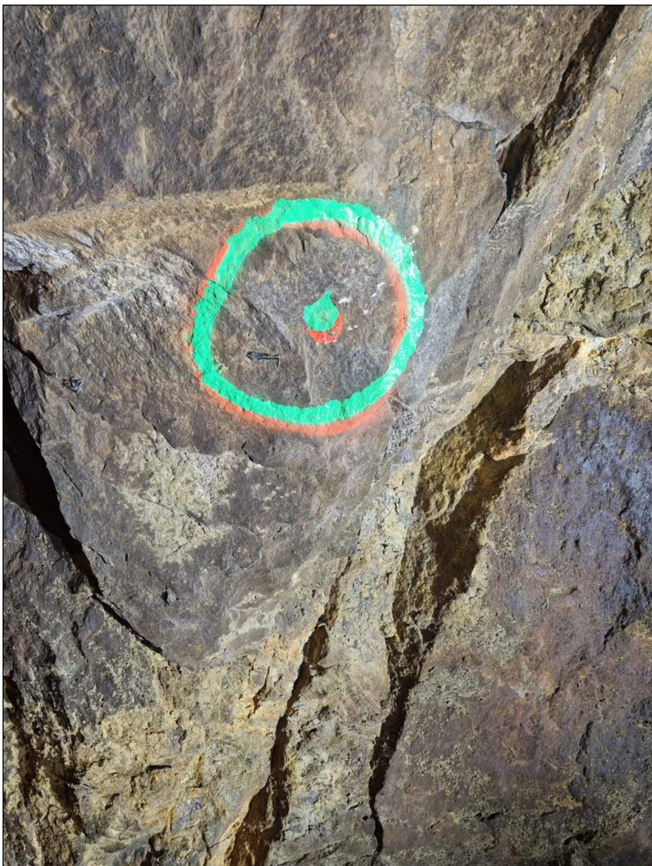
Foto 3. Tidligere merke for bombolt fra hovedinspeksjon 2020 er ikke satt. Anvist bolt ved hovedinspeksjon 2025. Pel.nr 763 heng-vederlag venstre side.
