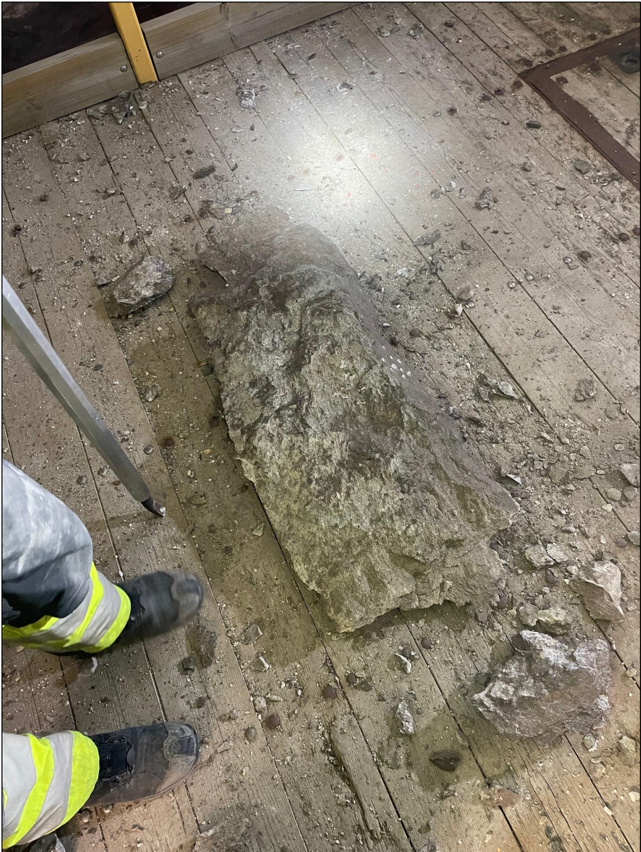
Foto 8. Tiltak og behov for rensk jevnlig i oppsprukket og småfallent bergpartier. Bilde er tatt ved pel. 255-260, fra nedrensket avløst blokk i vederlag- heng.
